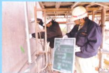
非破壊試験 超音波
