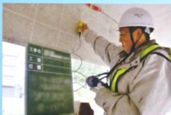
配筋状態及びかぶり測定
