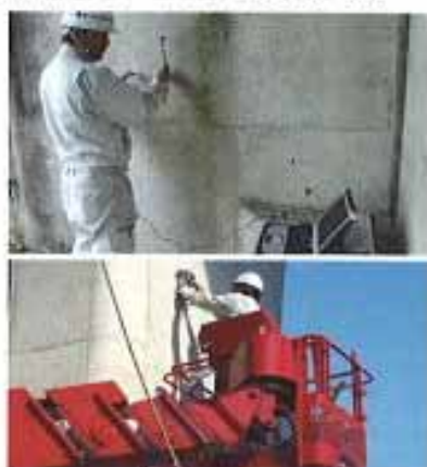
日本全国どこでも、地域の発展と活性化のために現場作業はもちろん技術指導にも行なうなど、多岐にわたるニーズに応えてくれる。
